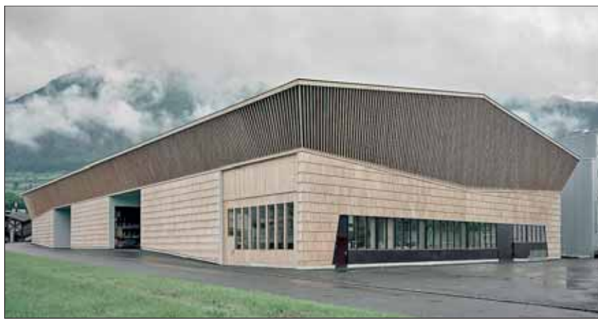
Die Werkhalle der Firma Küng in Alpnach (Schweiz) ist 78 m lang und 38 m breit. Die Fassadengestaltung aus großformatigen Holzschindeln unten und CNC-gefrästen Holzlamellen oben relativiert optisch die recht große Auskragung des Dachs. Foto: Seiler Linhart Architekten
