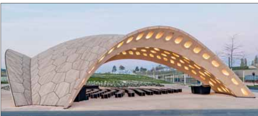
Maximale Spannweite bei minimalem Materialeinsatz: Mit einer Spannweite von 30 m bei nur 38 kg/m 2 Gewicht demonstriert die doppelt gekrümmte Holzschale des „Buga“-Pavillons die Möglichkeiten digitaler Technologien und deren strukturelle Leistungsfähigkeit. Die „gelochten“ Segmente boten zudem eine optimale Akustik bei der Nutzung des Pavillons für Konzerte. Fotos: ICD ITKE (2)
