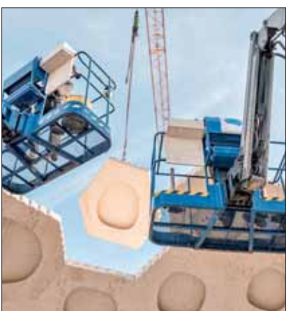
Montage der Segmentschale im freien Vorbau: Die einzelnen Hohlkassetten fügen sich wie Puzzleteile ineinander und sind so formstabil, dass kein Montagegerüst erforderlich war.
